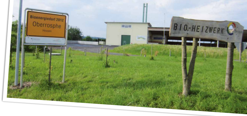
Biomasseheizwerk der Genossenschaft Bioenergiedorf Oberrospe eG, Stadt Wetter
