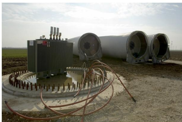
Baustelle eines Windparks
