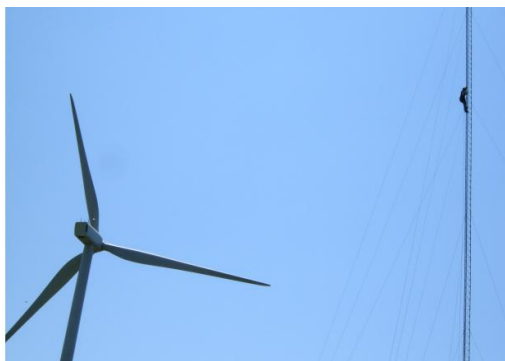
Installation eines Ultraschallaufnahmegeräts an einem Messmast zum Monitoring von Fledermäusen
