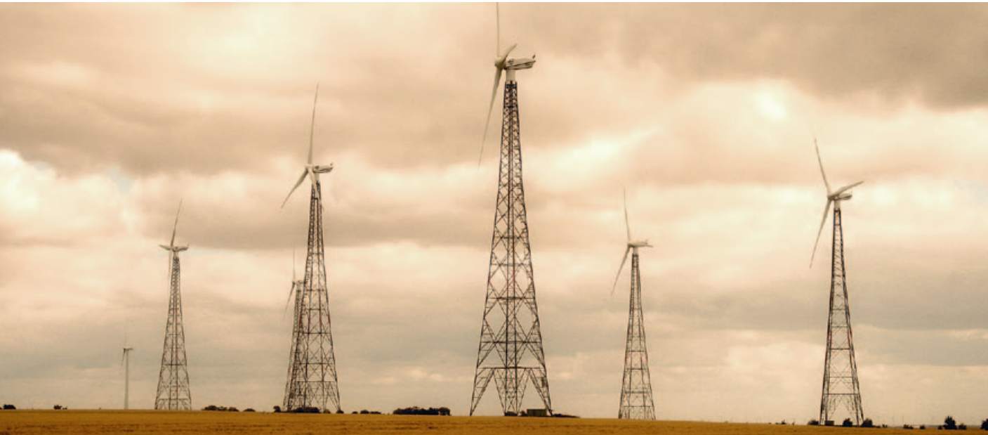
Zu Beginn der Windenergienutzung wurden auch Gittermasten eingesetzt, heute werden Turbinen auf Rohrtürme montiert.
