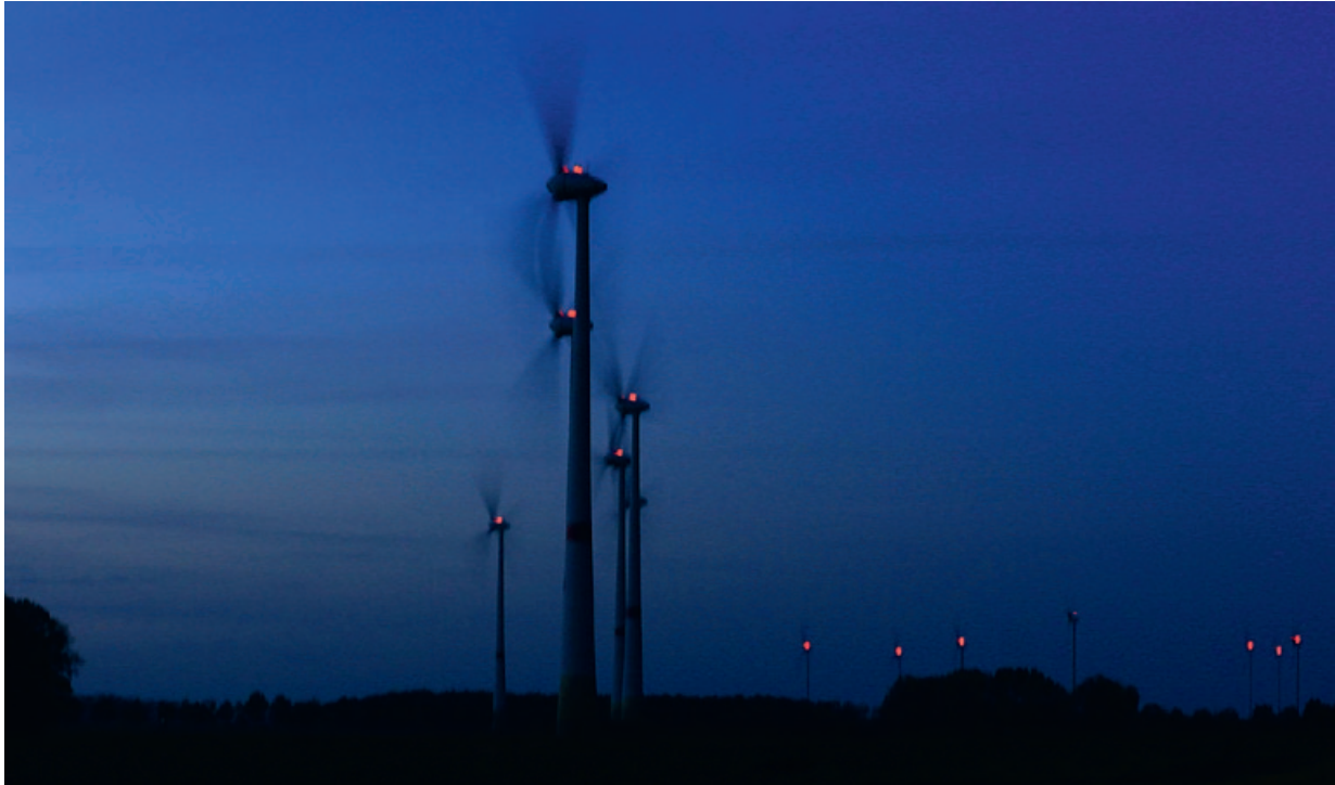
Synchronisiert blinkende rote Beleuchtung von WEA
