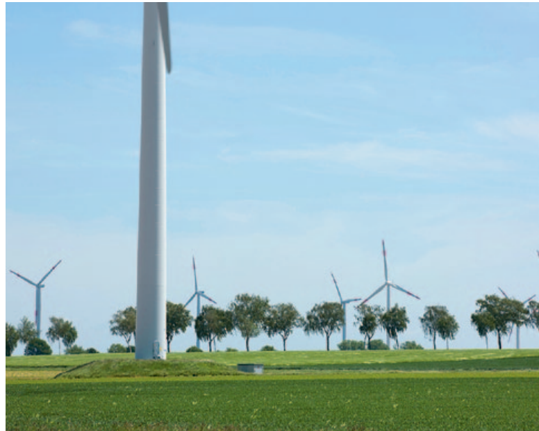
WEA mit deutlich sichtbarem grasbewachsenen Sockel im Mastfußbereich.
